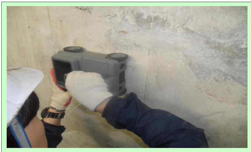
【Rc-Radar를 이용한 철근탐사 측정】
