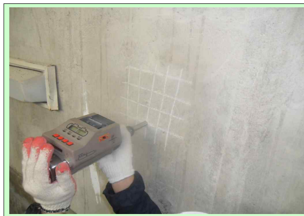
【반발경도법에 의한 강도 측정】
